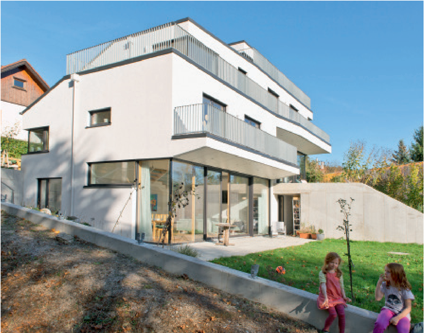
Das in Passivhausbauweise errichtete Doppelhaus ist mit einer Bauteilaktivierung ausgestattet, die beim Heizen und Kühlen die Wetterprognosen berücksichtigt.
