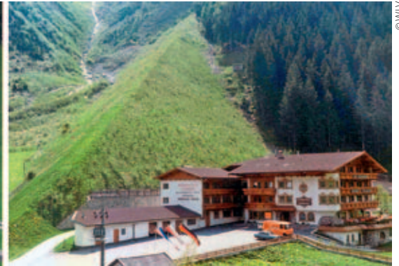
Ablenkdam zum Schutz eines Hotels; aus [1]
