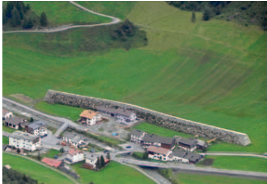
Abb. 3: Schutzbauwerke vor dem Gebäude: Auffangdamm aus Mauerwerk („Lawinenerdmauer“)
